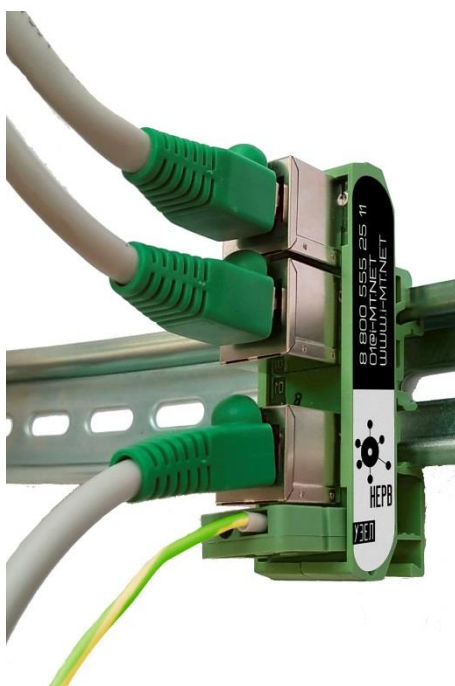
Рисунок 9.3 – Монтаж узла Нерв
