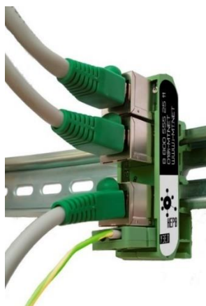
Рисунок 8.1 – Монтаж узла Нерв
