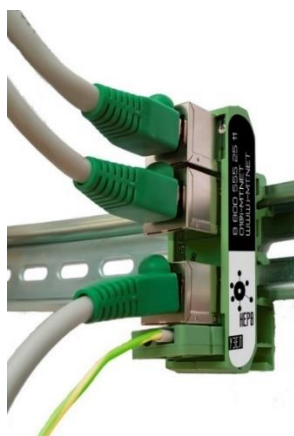
Рисунок 8.1 – Монтаж узла Нерв
